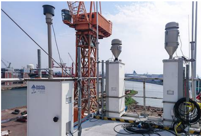
Die Lufteinlässe und Berner-Impaktoren auf dem Chemie-Container.
