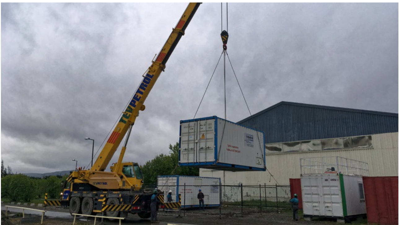
Installation der LACROS Messcontainer auf dem Gelände der UMAG. Foto: Martin Radenz, TROPOS.
