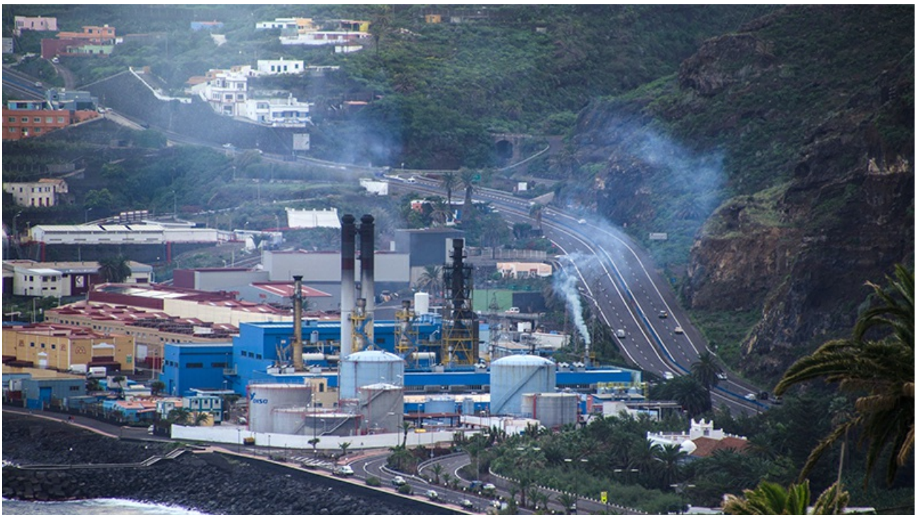
Diesel-Kraftwerk auf den Kanarischen Inseln. Die Reduktion der Ruß-Emissionen wäre ein Beitrag zum Gesundheits- und Klimaschutz. Foto: Tilo Arnhold, TROPOS
