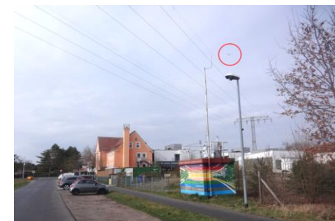
Messcontainer Mahlow, 6 km vom BER
