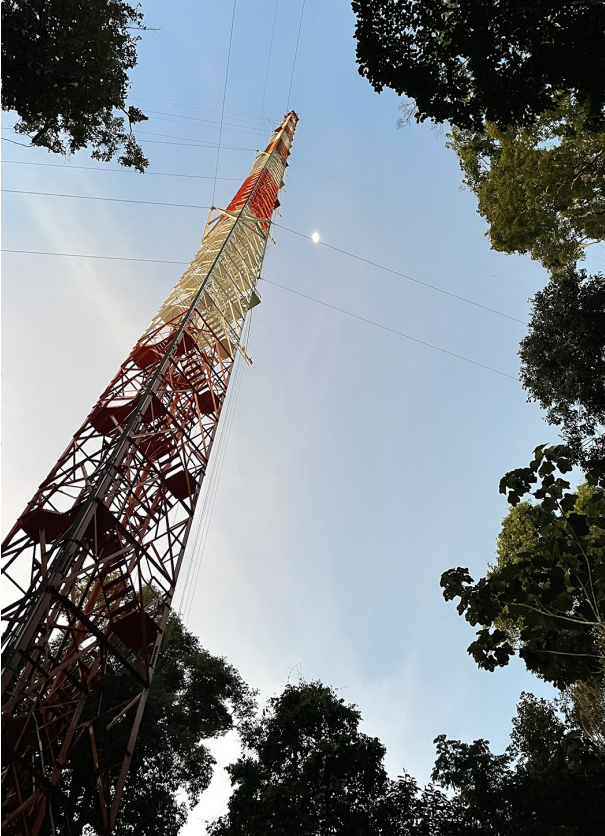
Fig. / Abb. 17: The ATTO Observatory (Amazon Tall Tower Observatory), with a 325-metre-high steel tower, is a research station in the Amazon rainforest, about 150 km north of Manaus. It is jointly operated by scientists from Brazil and Germany. TROPOS is involved in the measurements and evaluations through its cooperation with the MPIC. / Das Observatorium ATTO (Amazon Tall Tower Observatory) mit einem 325 m hohen Stahlturm ist eine Forschungsstation im Amazonas-Regenwald, etwa 150 km nördlich von Manaus. Sie wird gemeinsam von Wissenschaftlern aus Brasilien und Deutschland betrieben. TROPOS ist über die Kooperation mit dem MPIC an den Messungen und Auswertungen beteiligt. © Mira Pöhlker, TROPOS
