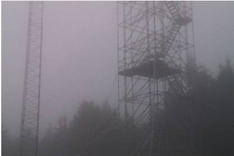
Foto des Messturmes auf der Schmücke
